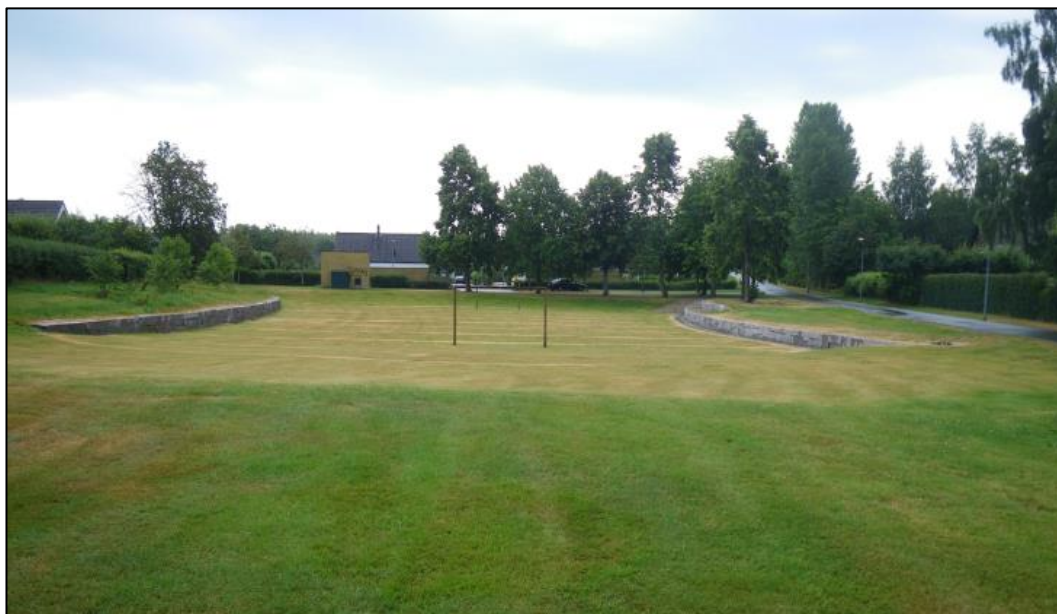
Figur 12: Exempel på dränerad fördröjningsyta som även används som fotbollsplan. Teleborg, Växjö. Foto: Sweco
