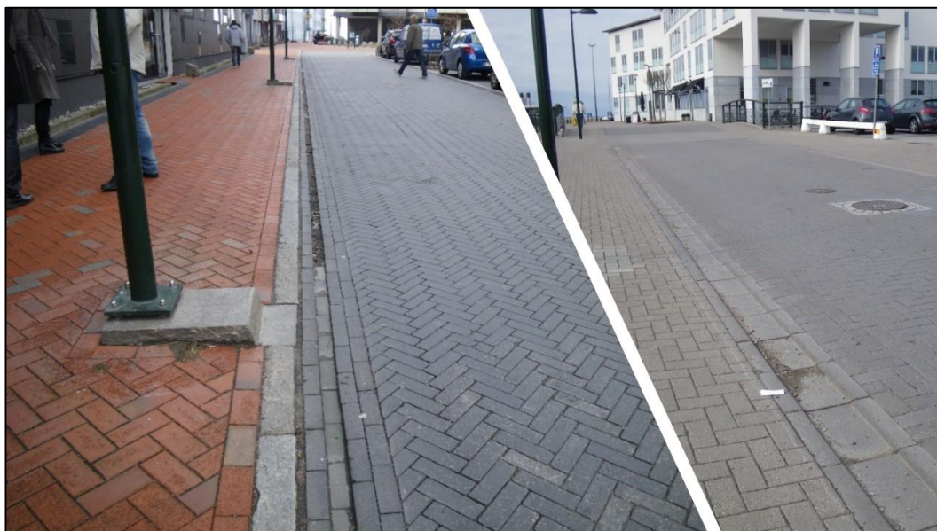
Figur 16: Exempel på öppna dagvattenrännor (Sweco, 2019).
