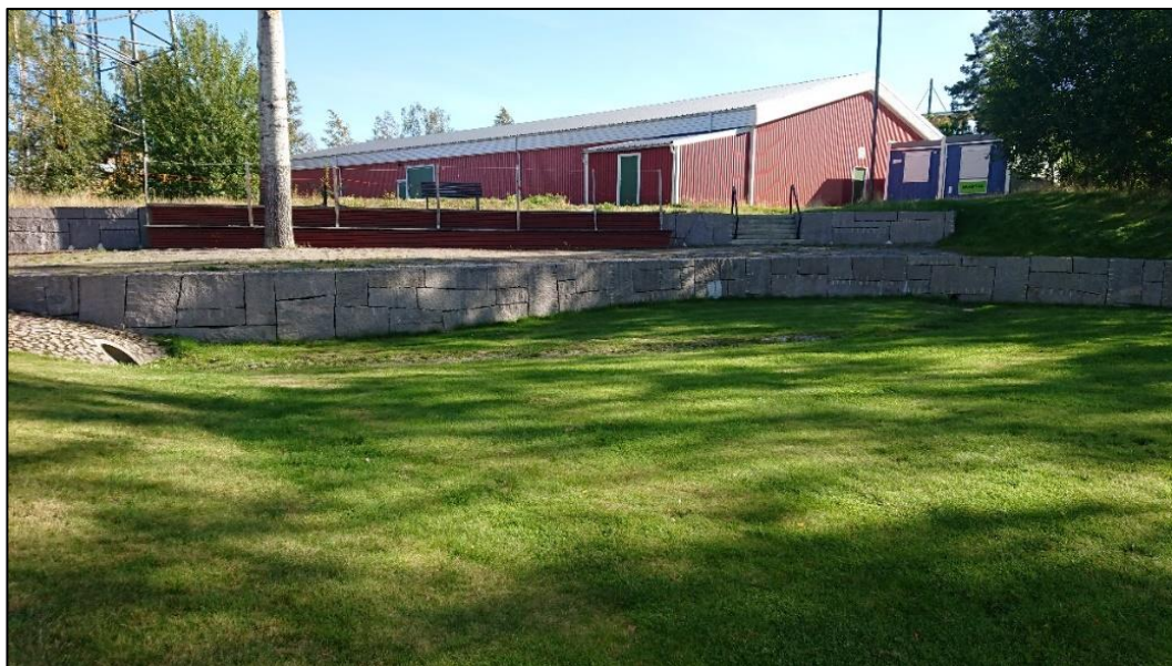
Figur 11: Exempel på fördröjningsyta skapad med tät stenmur och strypt ledning som utlopp. Fortnox, Växjö. Foto: Sweco
