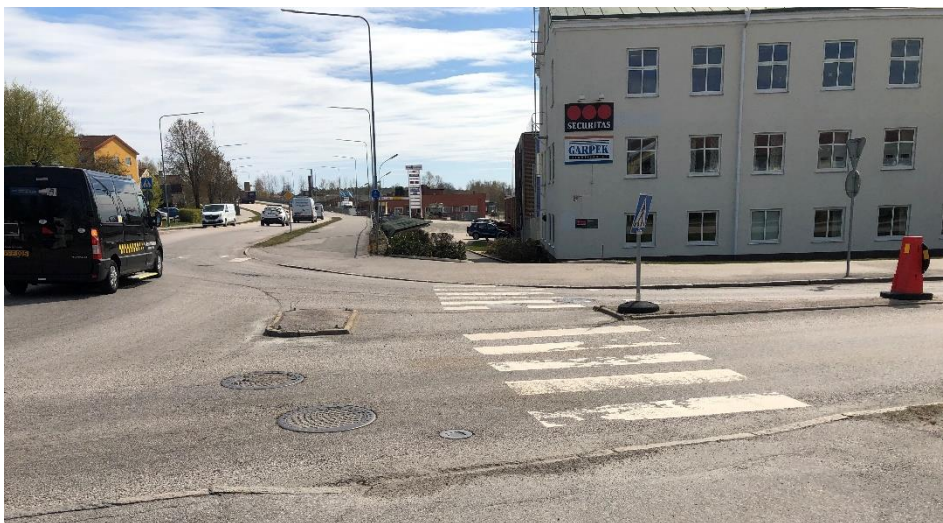
Figur 21 Övergångsställe över Folkparksvägen vid cirkulationsplatsen. Sliten målning och avsaknad av hastighetsdämpande åtgärder.
