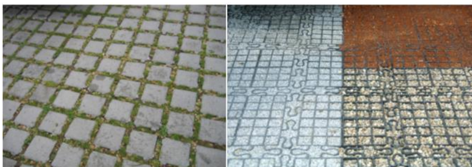
Figur 13: Genomsläppliga beläggningar. (Sweco, 2010).
