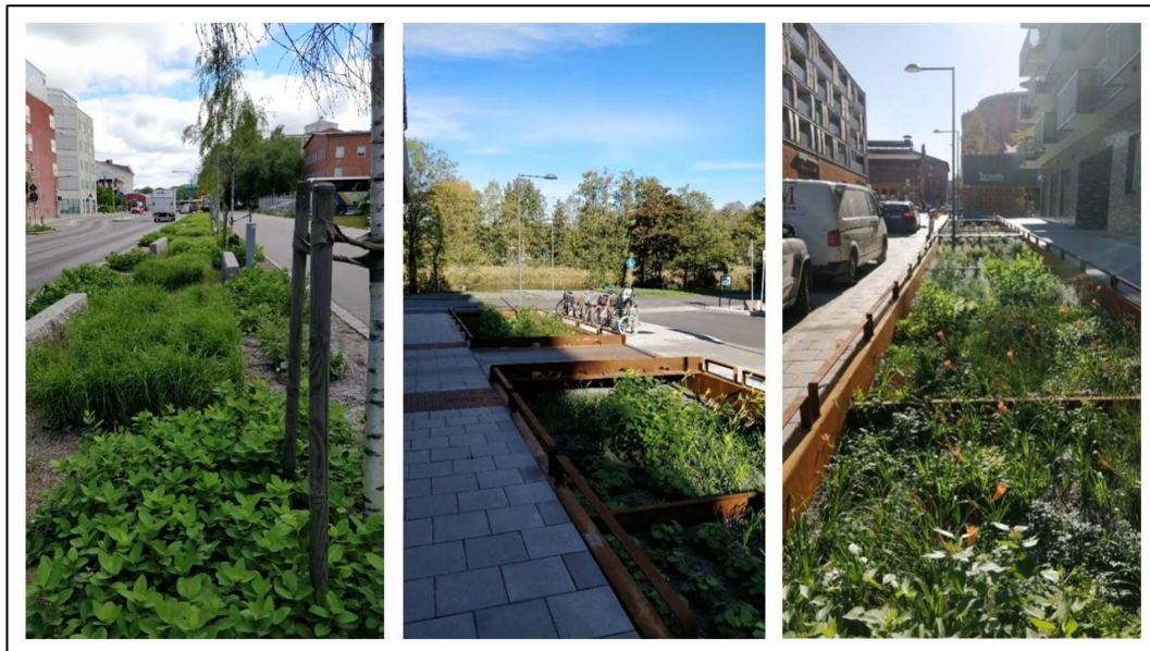
Figur 11: Exempel på regnbäddar längs gata. Foto Sweco.
