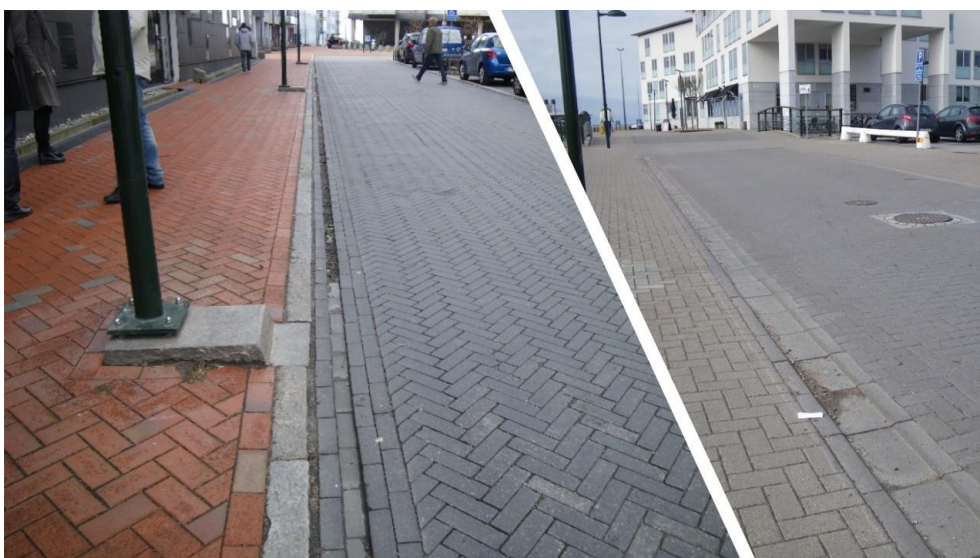
Figur 8: Exempel på öppna dagvattenrännor (Sweco, 2019).
