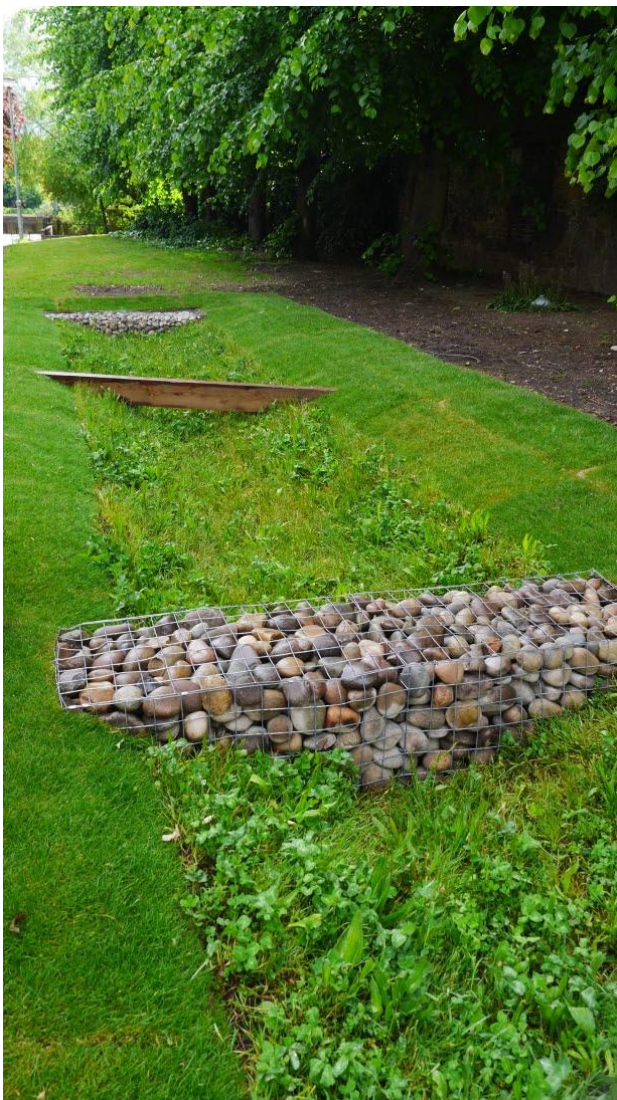
Figur 31. Exempelbild på ett trappat dike som fördröjer och utjämnar dagvatten, t.ex. vid skyfall (Foto: Boverket, 2020)
