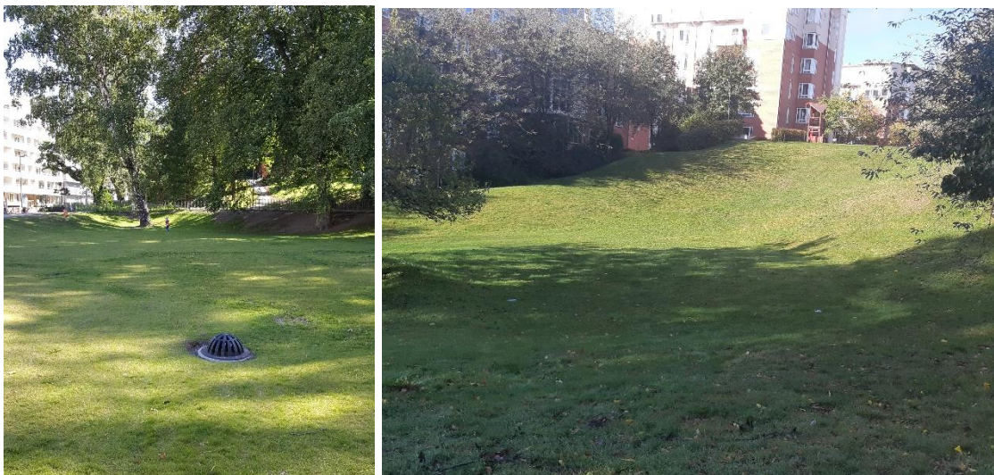
Figur 30. Exempel på större öppna ytor för utjämning med bräddavlopp. Gräsytan kan dräneras vilket innebär att ytan för det mesta är torr och utformningen anpassas till befintliga förhållanden (Foto: Tyréns)
