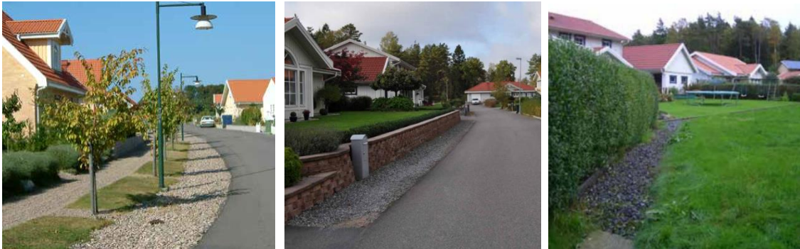
Figur 23. Exempelbilder makadamdike med krossmaterial i ytan. Diket till höger visar exempel på ett avskärande dike för att förhindra dagvatten från uppströms liggande mark att rinna in på grannfastigheten (Foto: Svalövs kommun, 2013)
