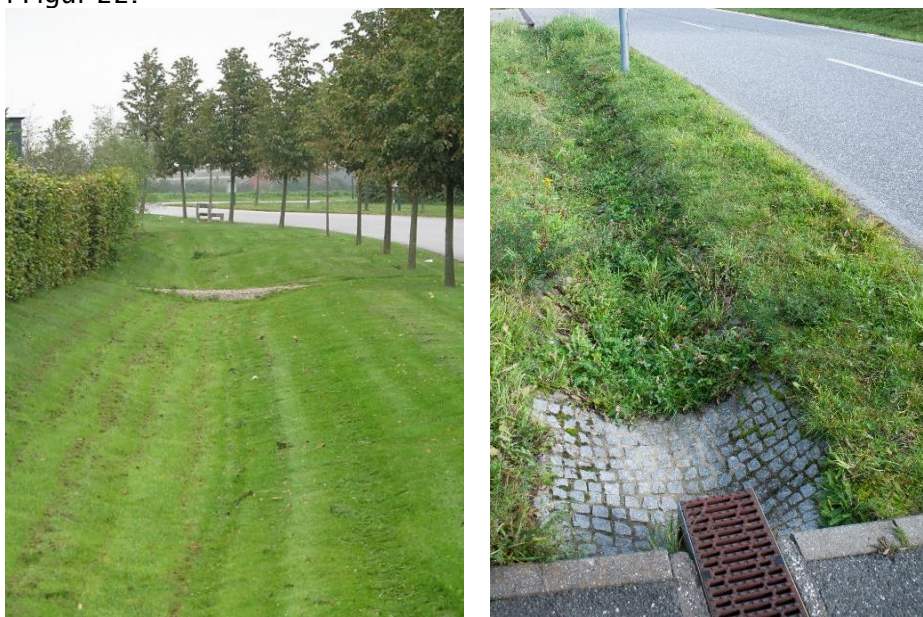
Figur 22. Exempelbilder på svackdiken (Foto: Tyréns)
