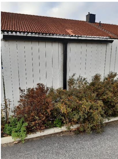
Figur 33. Exempel på befintligt lokalt omhändertagande av dagvatten direkt till rabatt inom kvarteret Topasen 2 (Foto: VME)
