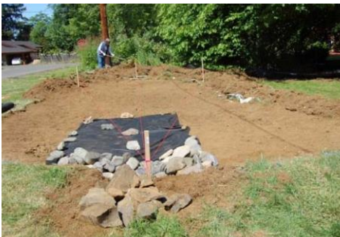
Figur 32. Erosionsskydd vid överfall av naturligt stenmaterial minskar risken för bortspolning av material vid större flöden (Foto: Oregon Sea Grant, 2009)
