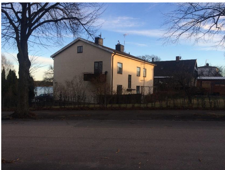
Befintlig byggnad inom planområdet sett från Tillbergsgatan.
