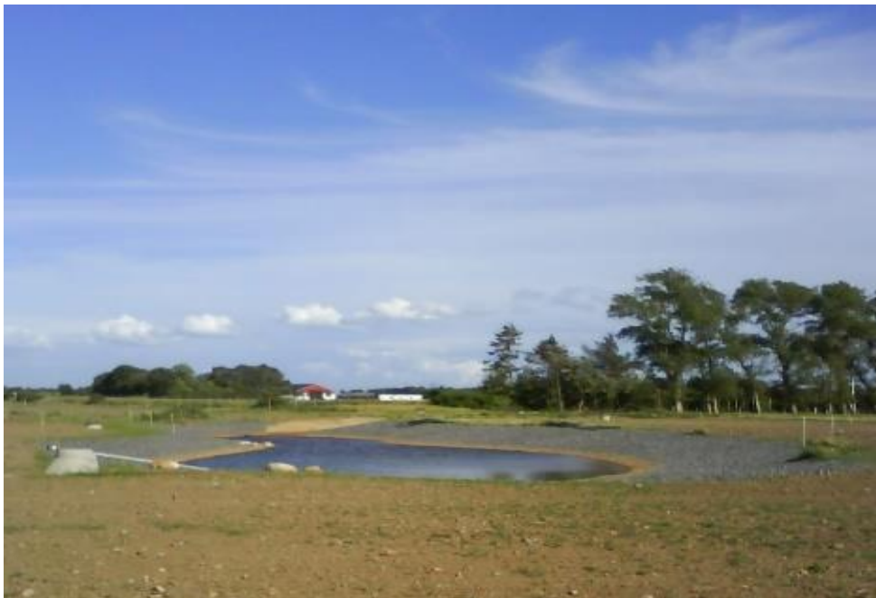
Figur 16 Exempel damm med översilningsyta. Källa: Sweco.
