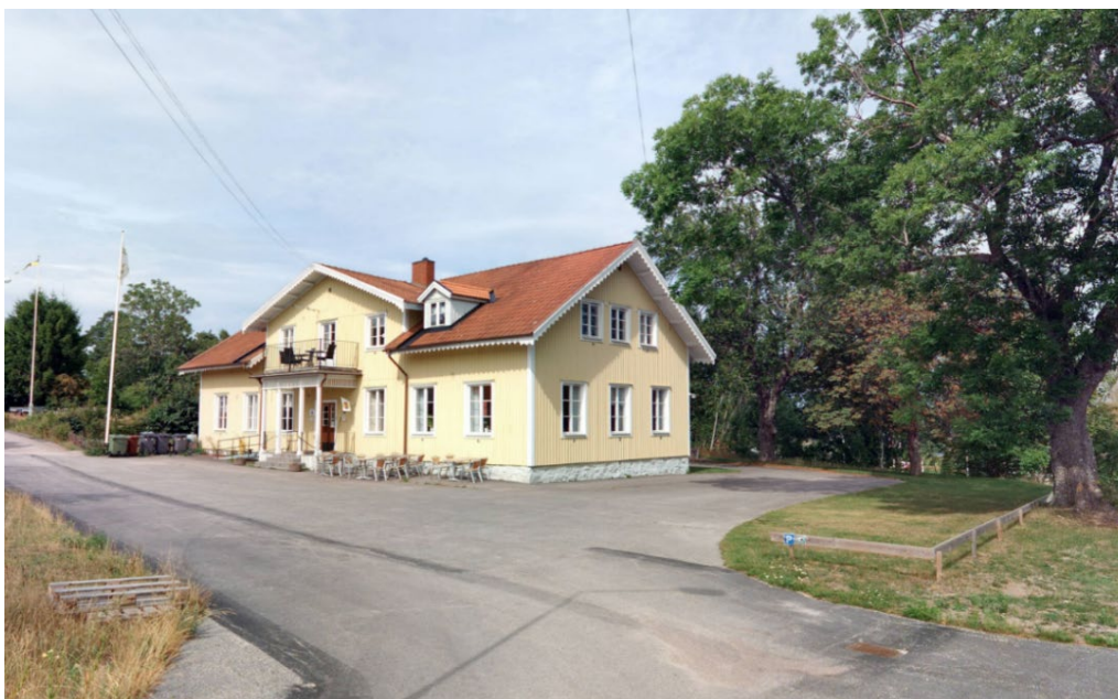
Figur 3: Fastigheten och dess huvudbyggnad sett från söder.
