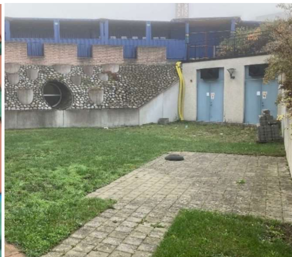
Foto: Lågmarkszonen invid stallverk utgör risk vid skyfall Bilden är tagen från Hus 20 i riktning byggnation Nyps N
