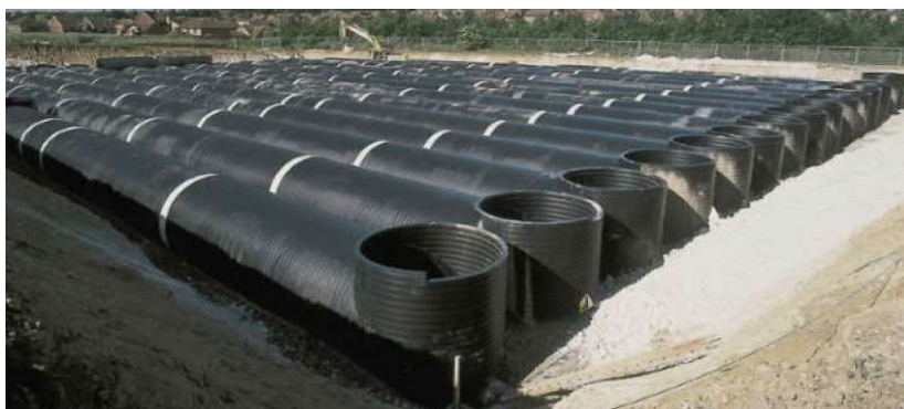
Figur 31 och Figur 32: Exempel på rörmagasin respektive filterbrunn (Flexiclean).
