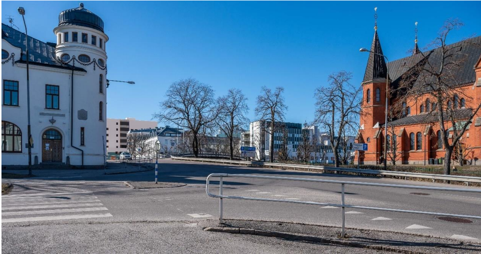
Bild 16. Vy nr 6. Befintlig situation (inkl. färdig psykiatribyggnad).
