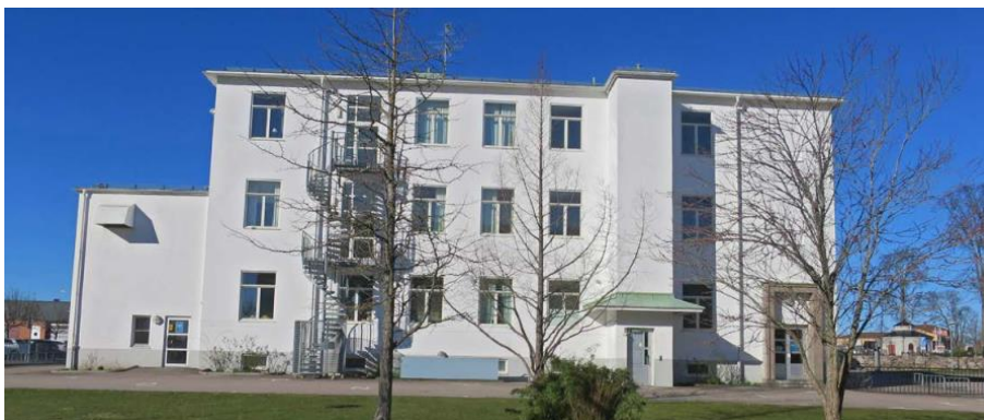
Bild 14. Läroverkesbyggnaden från 1936 i öster. Kalmar läns museum, 2021.
