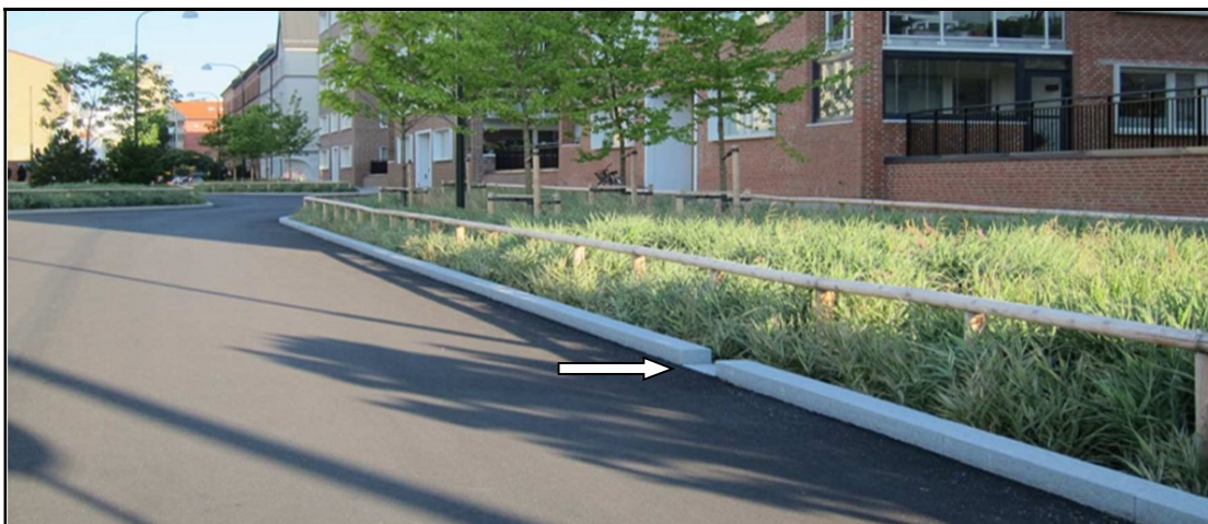
Foto 5. Bild på regnbädd från Monbijougatan i Malmö. Tillfälliga nedsänkningar i kantstenen (se pilen) fungerar som inlopp där dagvatten tar sig in i regnbädden. Källa: baramineraler.se
