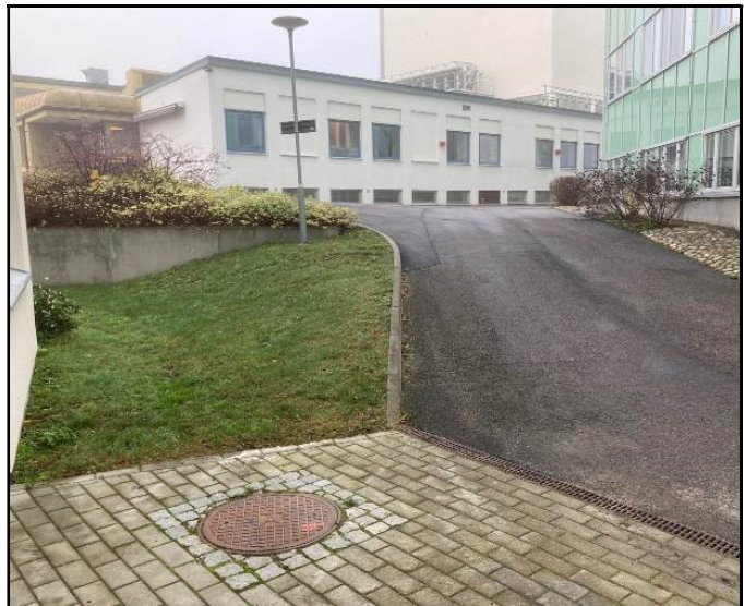
Foto 2. Sänkan vid Hus 20 mot Hus 04, 01
