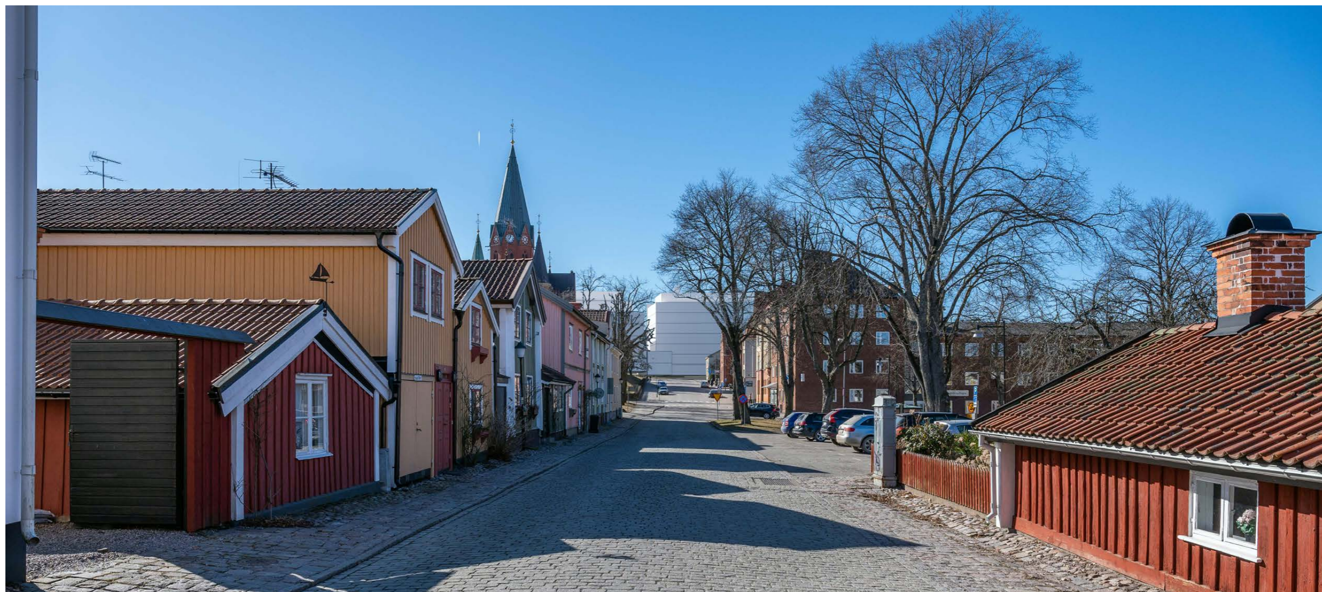
Montage av vy 11 när etapp 10 har genomförts. Montaget visar en modell av den volym som sjukhuset kommer utgöra. Montage: Atrio Arkitekter AB.
