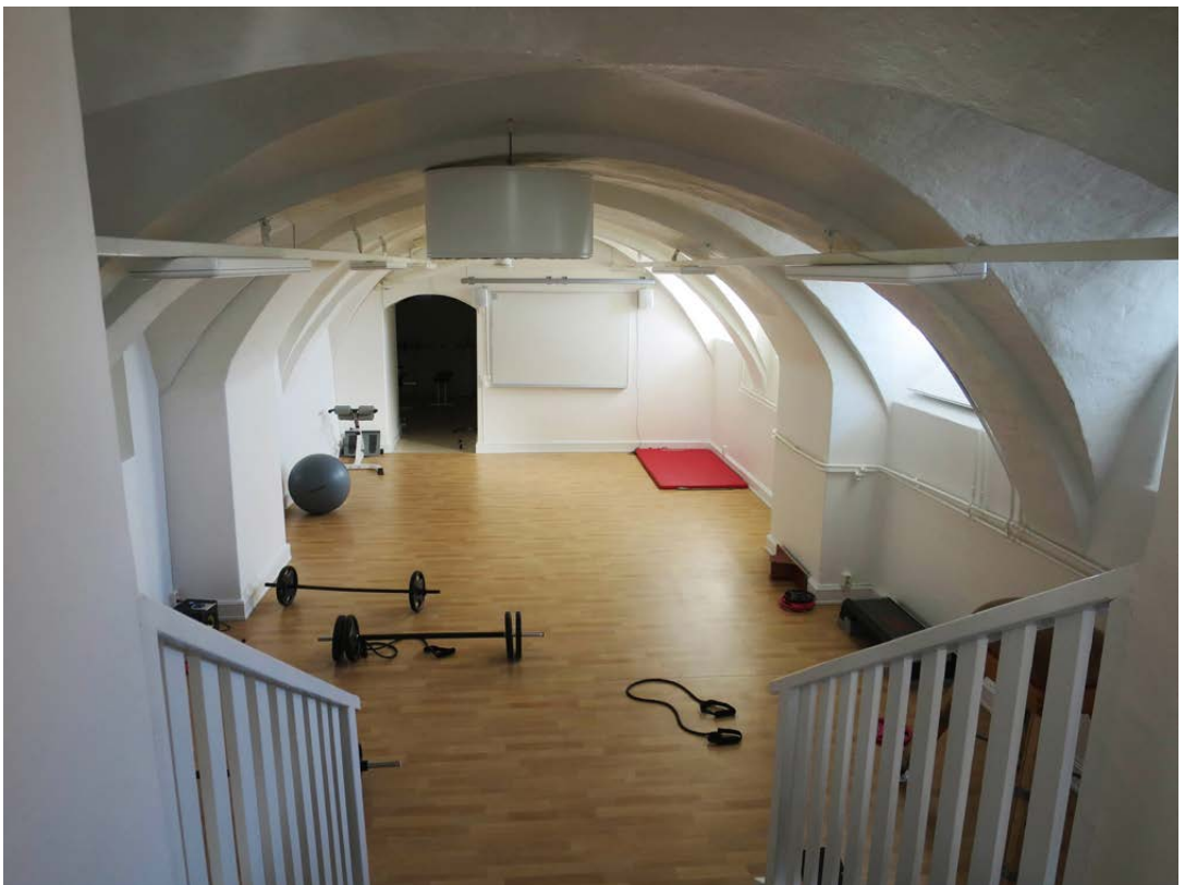
Källarutrymme i anslutning till gymnastiksalen. De bevarade valven ger karaktär åt rummet.
