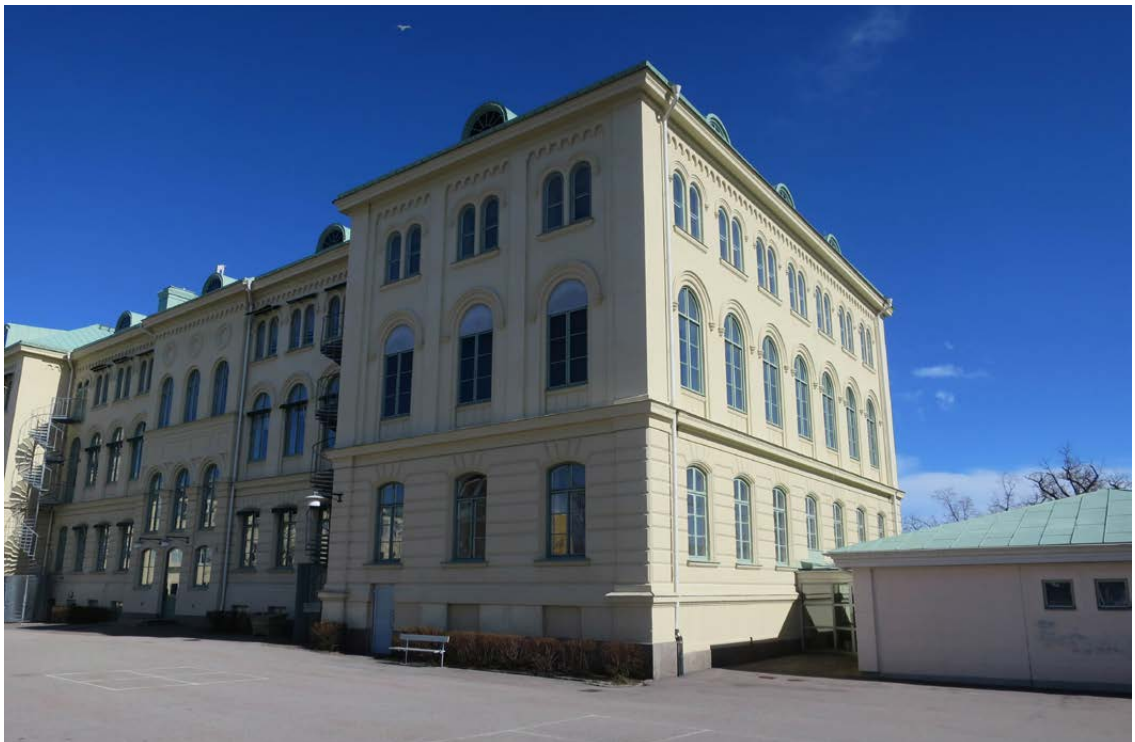
Fasaden mot söder. De stickbågiga fönstren i södra fasaden bottenvåning är troligen original från 1870. De har undgått den inklädning i aluminium som flertalet av skolans fönster har fått. Byggnadskroppen till höger tillkom 2001 och rymmer omklädningsrum och förbindelsegång till gymnastiksalen.
