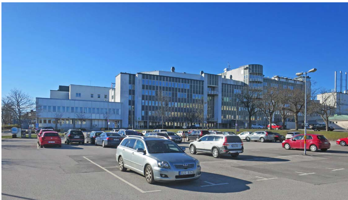
En av sjukhusets större byggnadskroppar som växer sig högre från Kyrkogatan och västerut.
