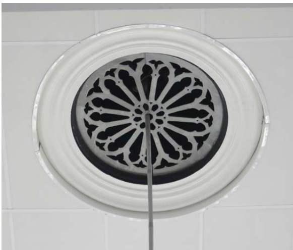
Takkronornas anslutning till taket med ventilationsgaller i gjutjärn.
