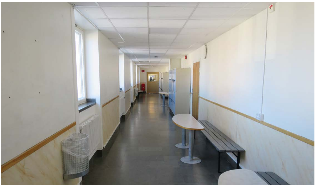
De långa korridorerna mot Kvarngatan, till vänster i bild, och dörrarna mot klassrummen in mot skolgården, till höger i bild, utmärker byggnadens planlösning. Kalkstengolvet, fönsterbänkarna av kalksten och flänsradatorerna är tidstypiska för 1950-talet.
