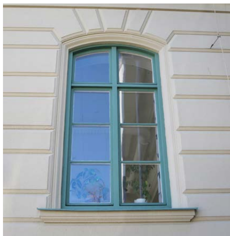
Ett av de rundbågiga fönstren på andra våningen med putsdekor i nyromansk stil. Bågar och spröjs har klätts in med aluminium.
