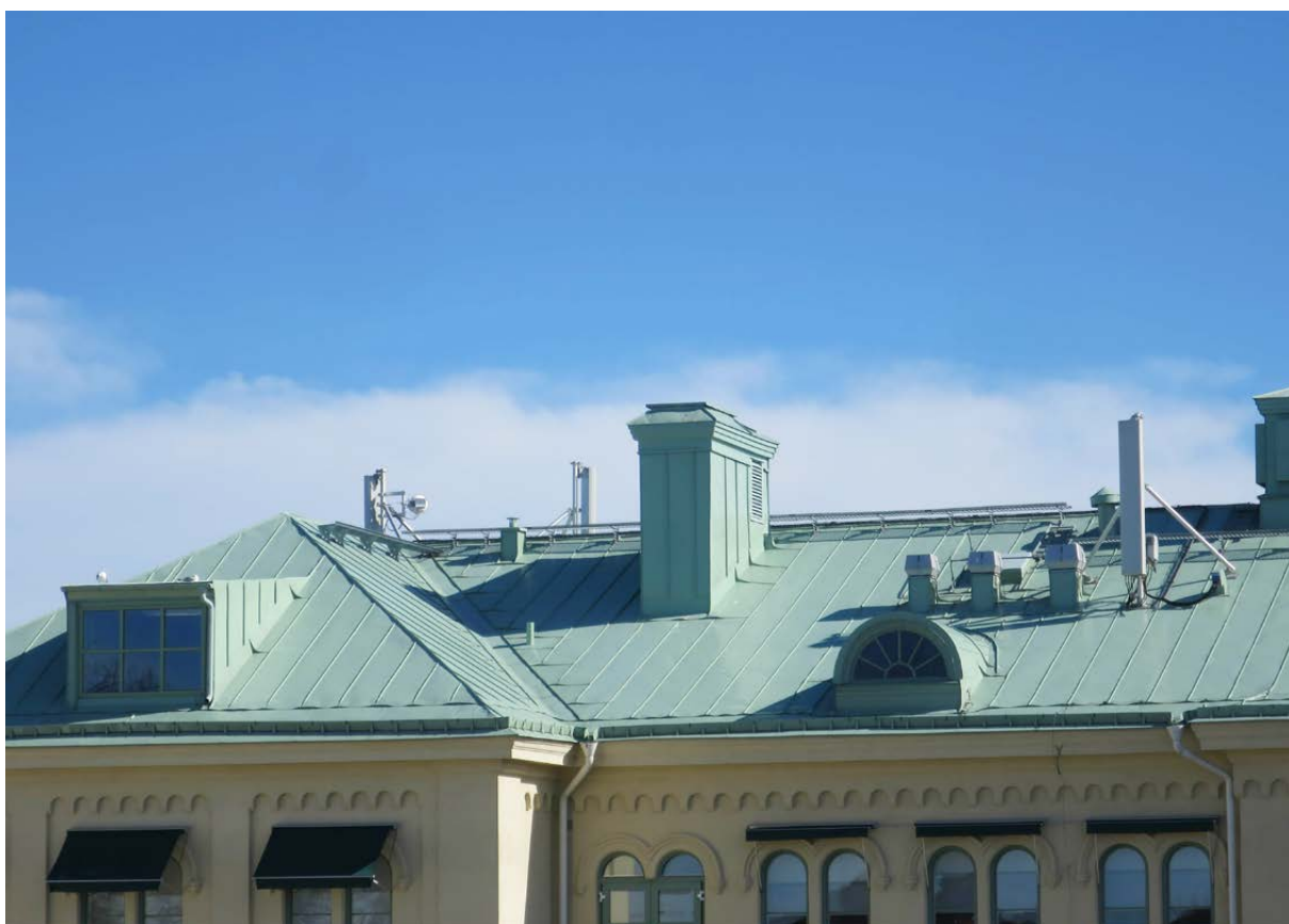
Delar av taket mot söder.
