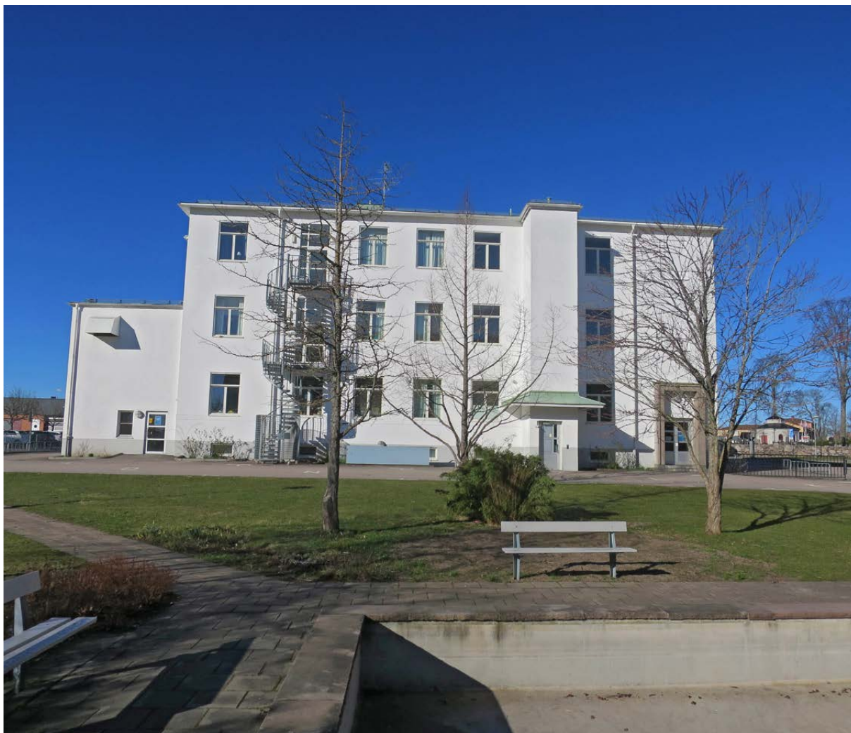
Läroverksbyggnaden från 1936 från öster.
