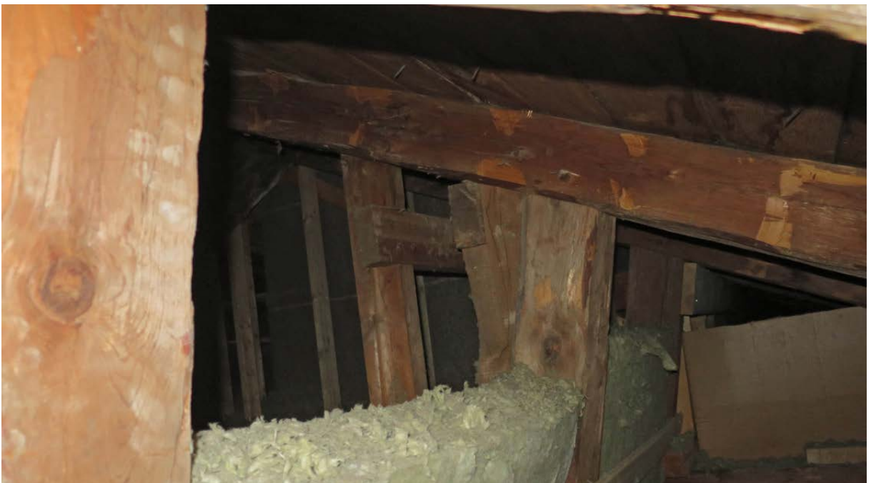
Tätt ställda takstolar av kraftigt virke med tydliga spår av bearbetning med yxa bär upp den gamla läroverksbyggnadens tak.
