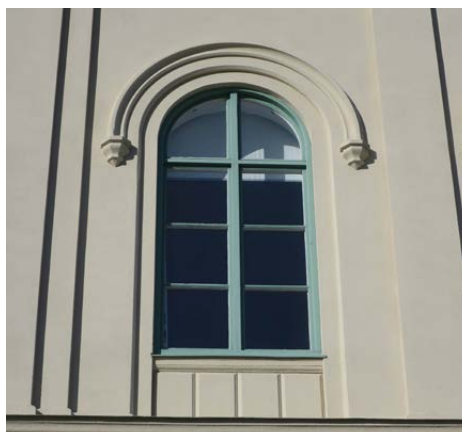
Ett av bottenvåningens stickbågiga fönster som klätts med aluminium.
