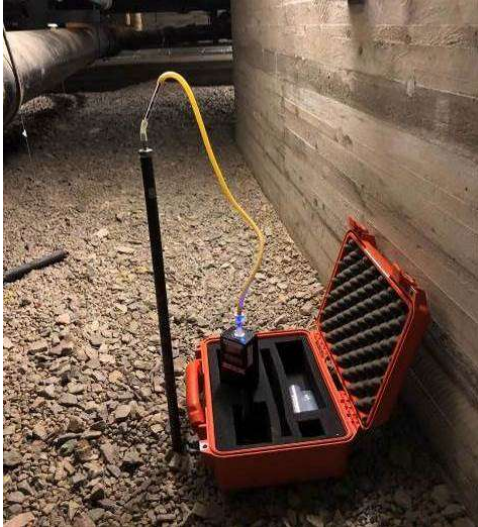
Porgasmätning vid K (underkulvert)
