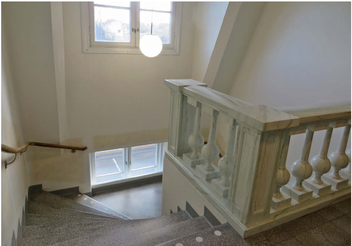
Det marmorerade räcket högst upp i trapphuset. Golvet belagt med terrazzo och svarvad handledare från 1950-talet. Armaturen är typisk för tiden.
