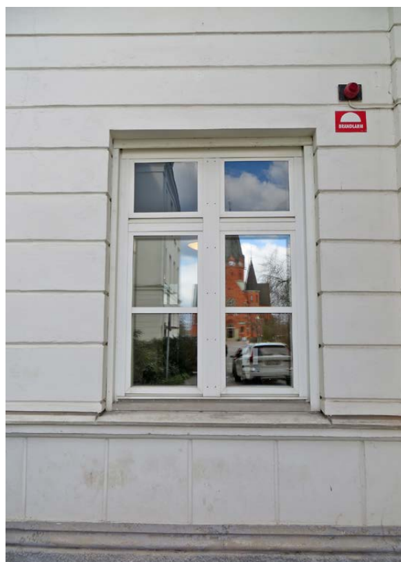
Exempel på fönster i hus 3.
