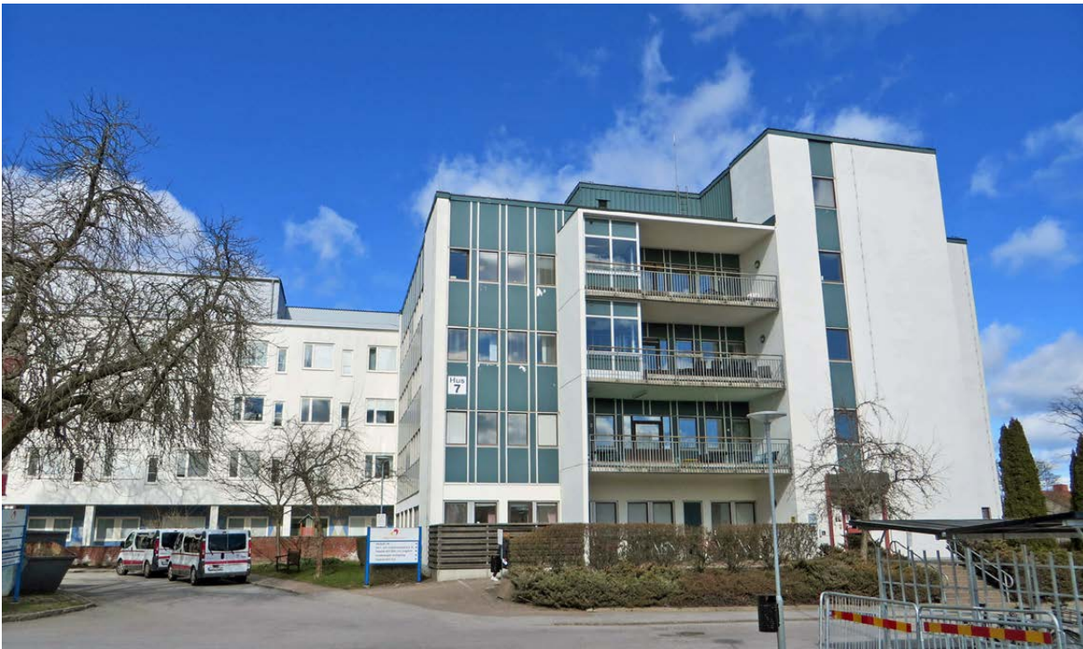
Till vänster i bilden syns Löfströms byggnad från 1956 som var den första delen av hus 7 som uppfördes.
