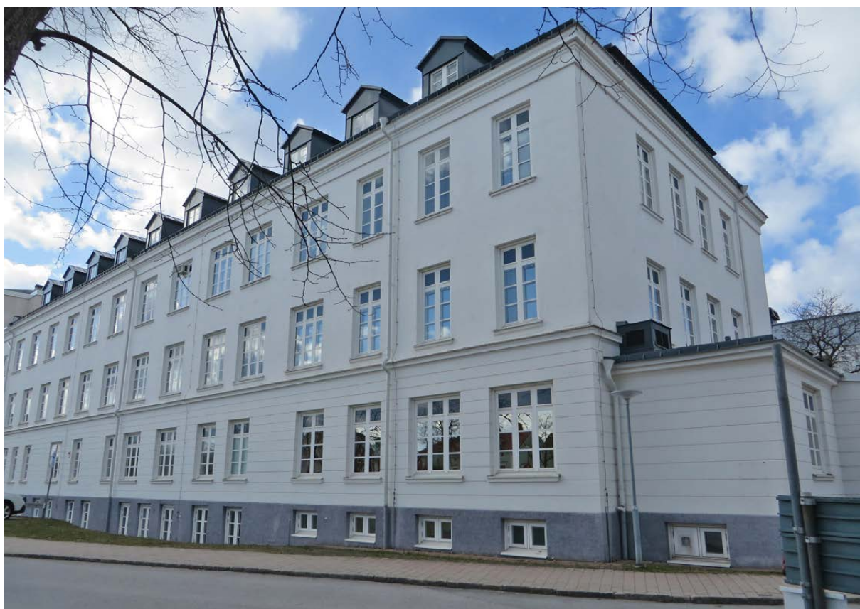
Hus 3 från sydost.
