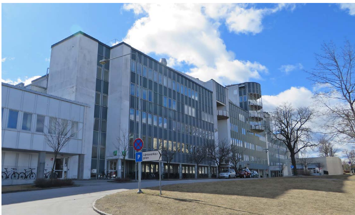
Hus 11 från nordost. Närmast i bilden den senaste tillbyggnaden av huset som gjorts efter 1995.
