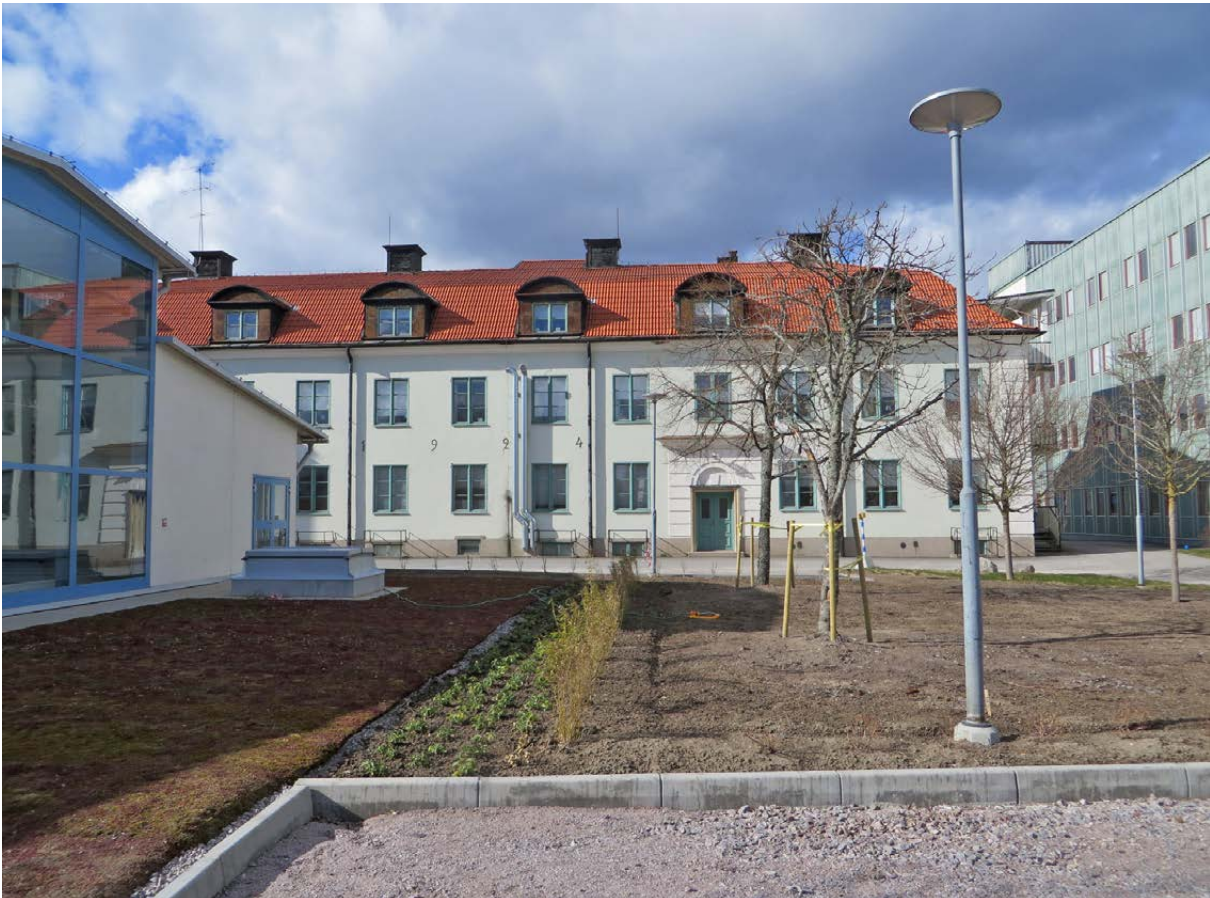
Hus 9 från söder.
