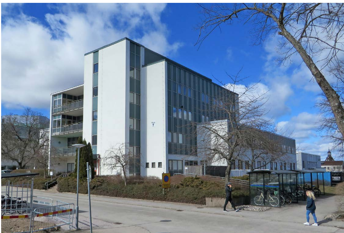
Hus 7 från sydost.
