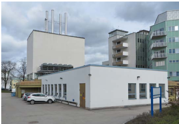
Hus 4 från söder.
