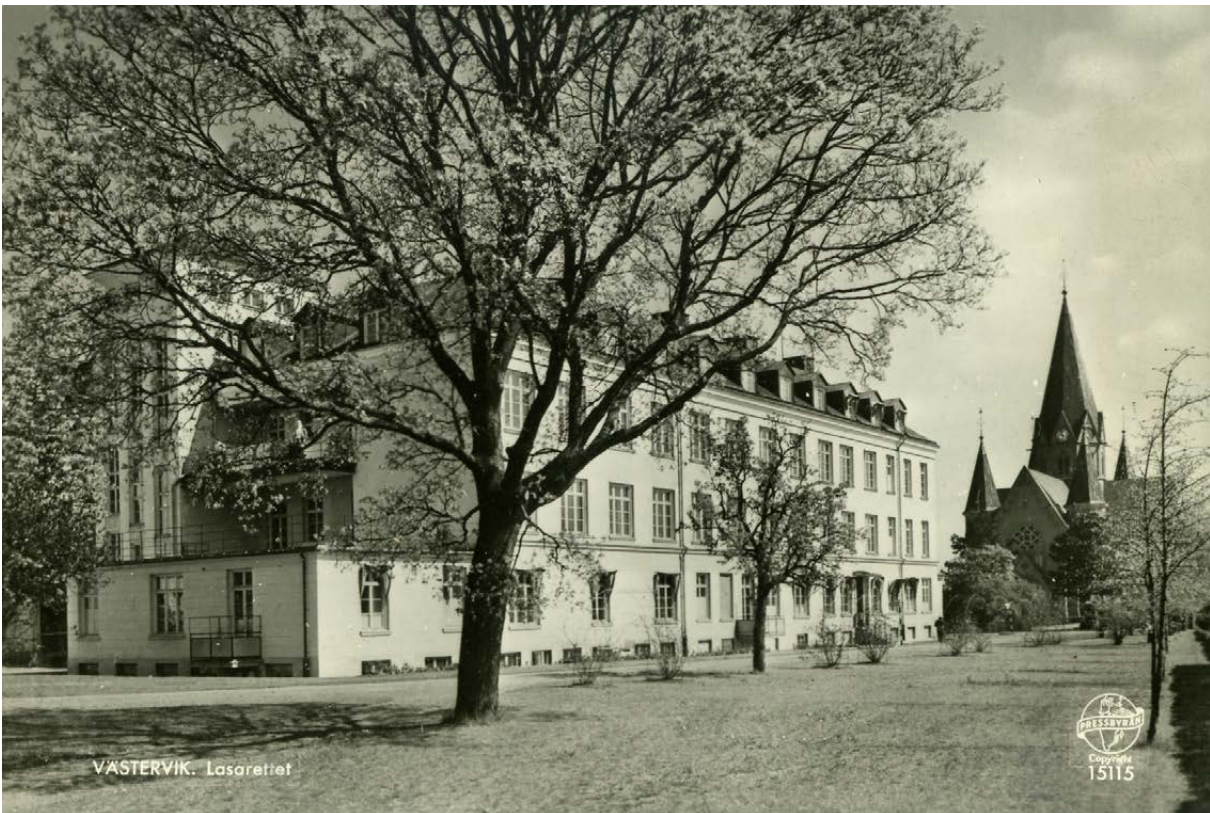
Odaterat foto men troligen från 1940-talet. Till vänster i bilden syns det trapphus som då förband hus 3 med områdets äldsta sjukhusbyggnad och idag förbinder hus 3 med hus 21. Man ser också hur hus 3 såg ut före ombyggnadens på 2000-talet. Till höger i bilden Sankt Petri kyrka. Källa: Västerviks museums samlingar
