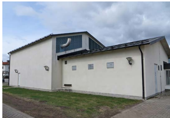
Hus 8 från söder
