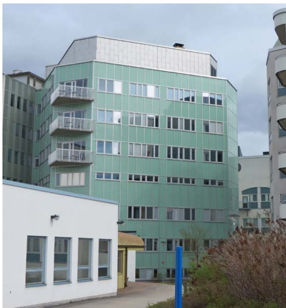
Hus 1 från söder.
