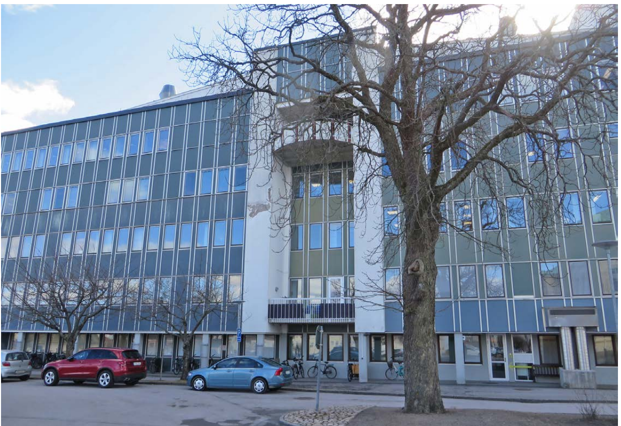
Den långa fasaden mot norr bryts upp av ett markerat parti med balkonger. I bottenvåningen finns en arkad med fyrkantiga pelare. Balkongerna och våningsplanen högst upp tillkom vid ombyggnaden 1995.
