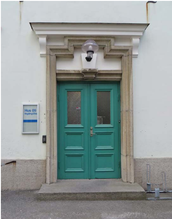
Dörr med omfattning mot norr.
