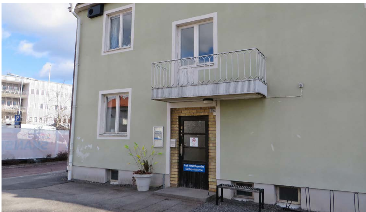
Dörrparti och balkong.
