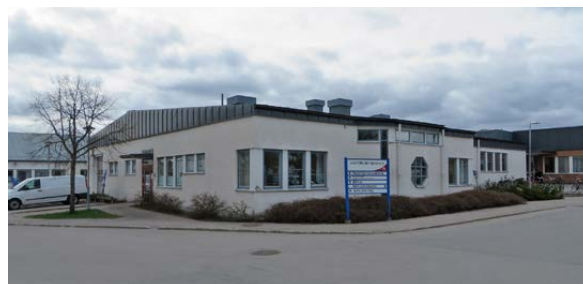
Hus 5 från nordost.
