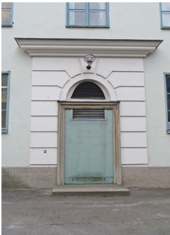
Exempel på utbytt dörr mot norr.
