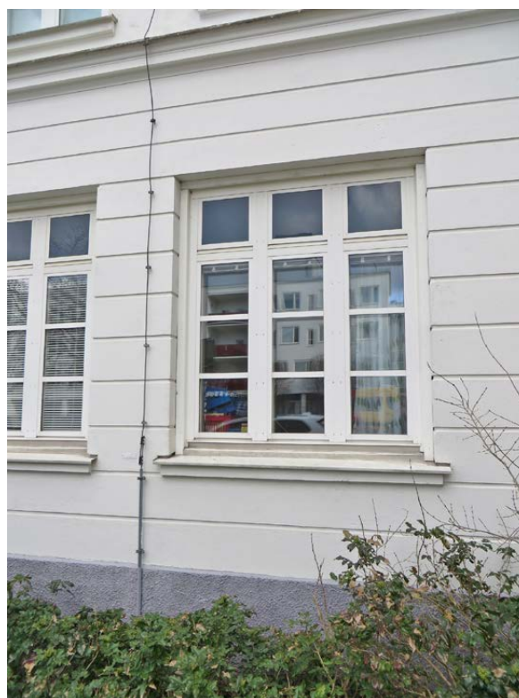
Exempel på fönster i hus 3.
