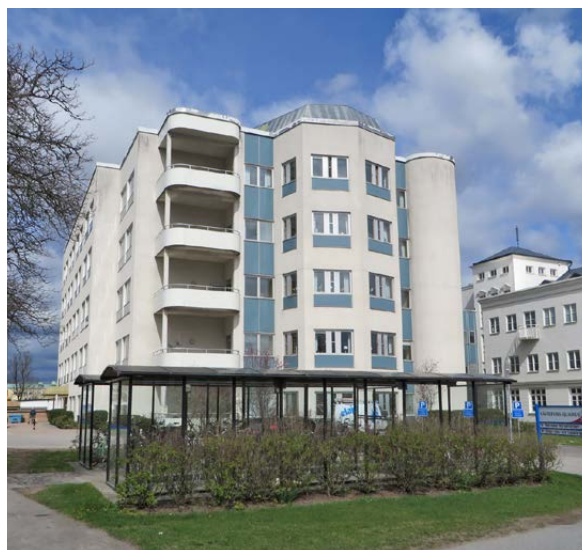
Hus 20 från söder.
