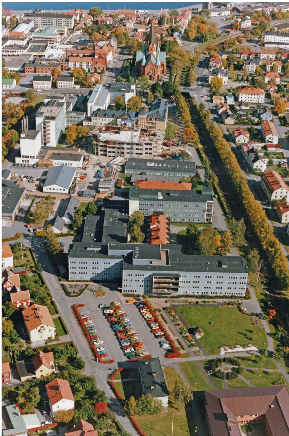
Flygfoto från slutet av 1980-talet. Hus 20 håller på att byggas. Antalet gröna ytor har drastiskt minskat.
