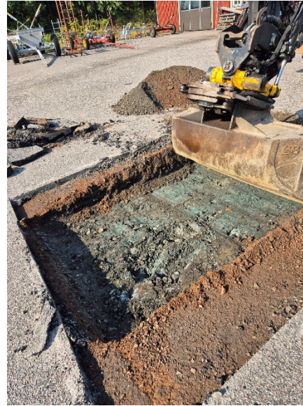
Figur 5. PG 11. Fyllning med grusig sandig lera. Innehåller halter över KM.
